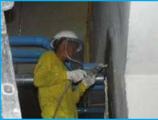
PU Foam Injection
